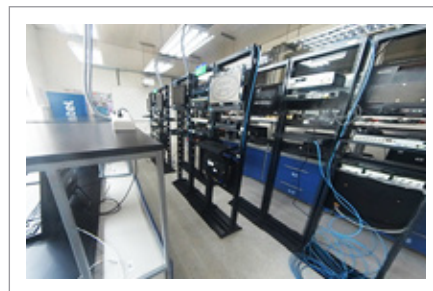
Laboratorio de Telecomunicaciones de Liceo Industrial Fundación F. W. Schwager
