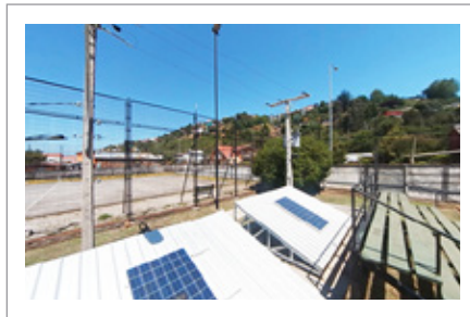
Patio de Entrenamiento Eléctrico de Liceo Bicentenario de Excelencia Industrial de Tomé
