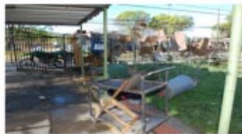
Desorden, suciedad y destrucción de mobiliario en Pasillo de Ingreso a Liceo
