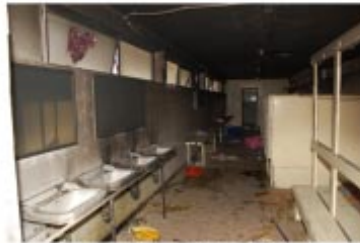
Quemas, destrucción, rotura de vidrios y rasguños de paredes de Duchas Alumnas
