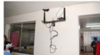
Desorden, TV monitor colgando y destrucción de equipos e instalaciones
