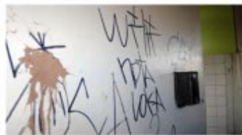
Rayado en muro azules Bello Varones Primer Piso
