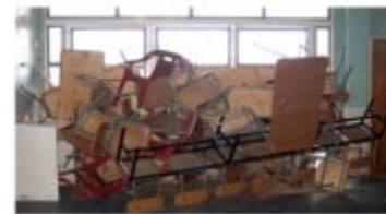
Rotura de vidrios en puerta acceso a Liceo
