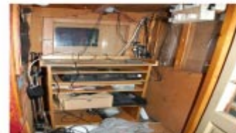
Desorden e instalación de material, destrucción de equipos e instalaciones de oficina sin inventario de materiales
